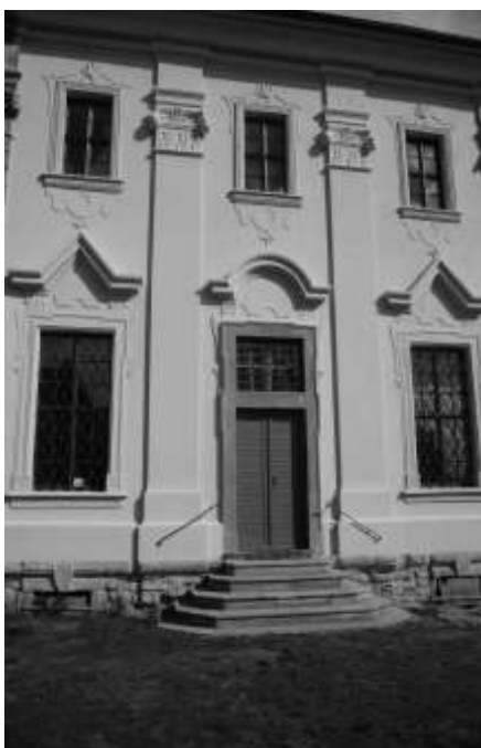
Tak nyní vypadá opravený vstup do kláštera.
